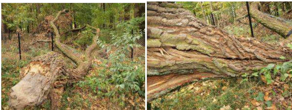
Fot. 23 - 26: Dąb szypułkowy ( Quercus robur ), nr 6 i 7; złamany konar, widoczna dziupla, pęknięcie podłużne i . ul. Paproci. 8.10.2014
