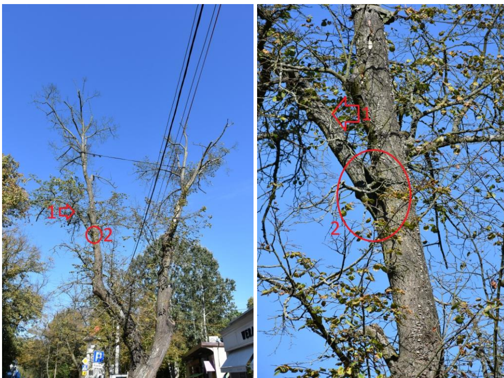
Fot. 19-20. Konar strukturalny (1) ze zrostem V-kształnym z pęknięciem pod zrostem (2)
