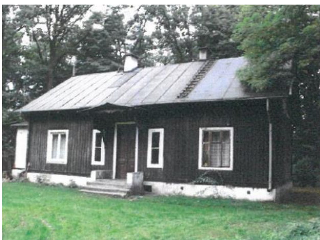
Fotografia 153. Dom przy ulicy Cichej (działka nr ewid. 239, obręb 12)
