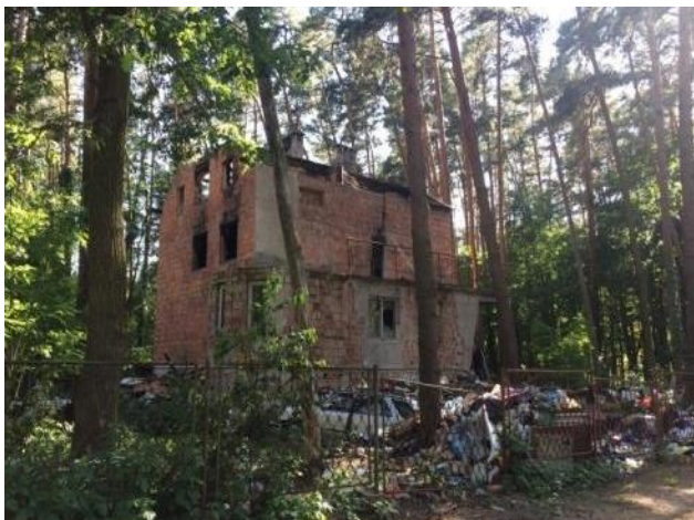
Fotografia 203. Miejsce wymagające poprawy stanu ładu przestrzennego: ulica Cicha – zniszczony budynek oraz składowisko odpadów
