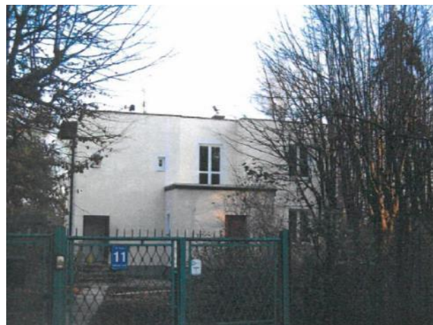
Fotografia 113. Dom przy ulicy Cichej (działka nr ewid. 123, obręb 12)
