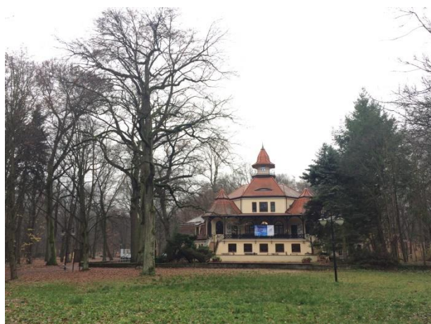
Fotografia 59. Pałacyk Kasyno Fotografia własna
