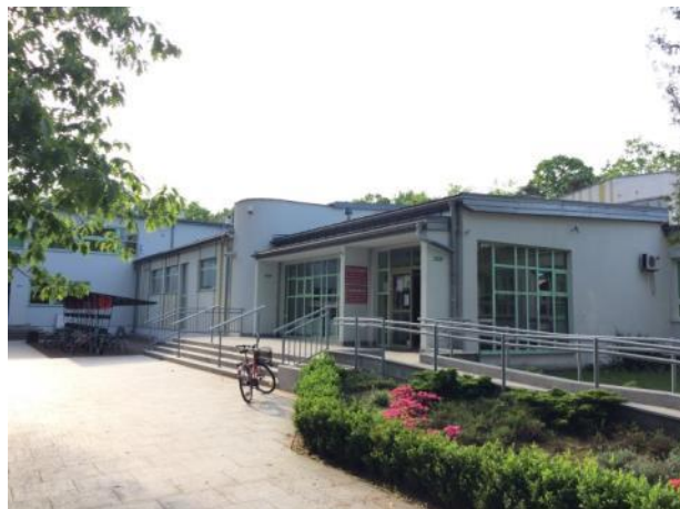
Fotografia 55. Publiczna szkoła podstawowa przy ulicy Modrzewiowej Fotografia własna
