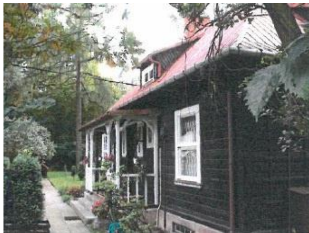
Fotografia 152. Dom przy ulicy Cichej (działka nr ewid. 110, obręb 12)
