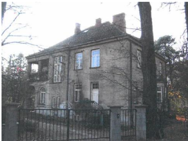
Fotografia 72. Dom przy ulicy Słowiczej (działka nr ewid. 222, obręb 2)
