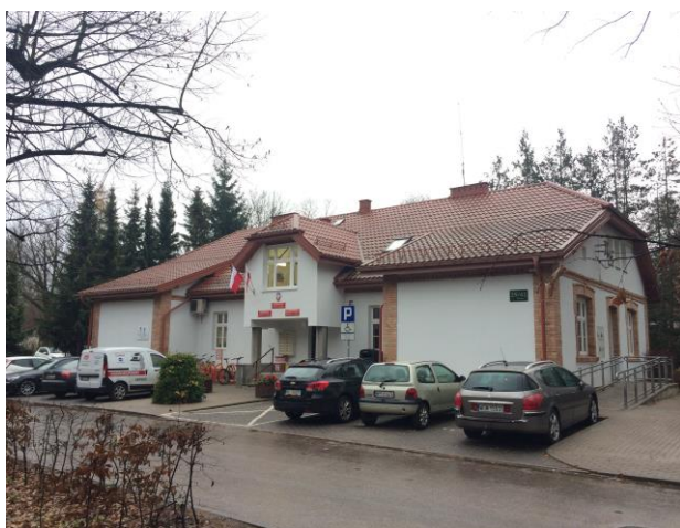
Fotografia 239. Budynek Urzędu Miasta Fotografia własna
