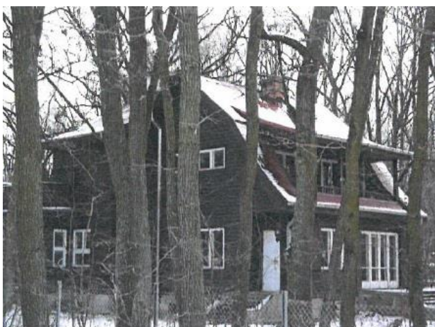
Fotografia 155. Dom przy ulicy Kwiatowej (działka nr ewid. 41, obręb 8)
