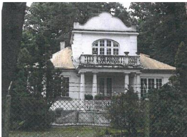
Fotografia 82. Willa Marysin przy ulicy Słowackiego (działka nr ewid. 141, obręb 10)
