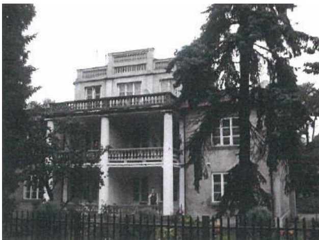
Fotografia 140. Dom wielorodzinny przy ulicy Jeleniej (działka nr ewid. 99, obręb 6)
