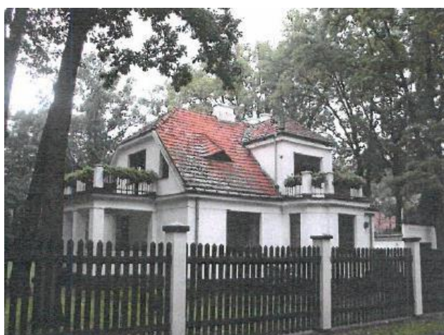
Fotografia 76. Willa Mirando przy ulicy Zachodniej (działka nr ewid. 204, obręb 2)
