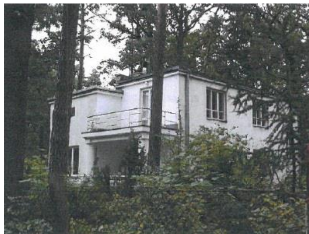
Fotografia 141. Willa Koloryt przy ulicy Sienkiewicza (działka nr ewid. 113, obręb 10)
