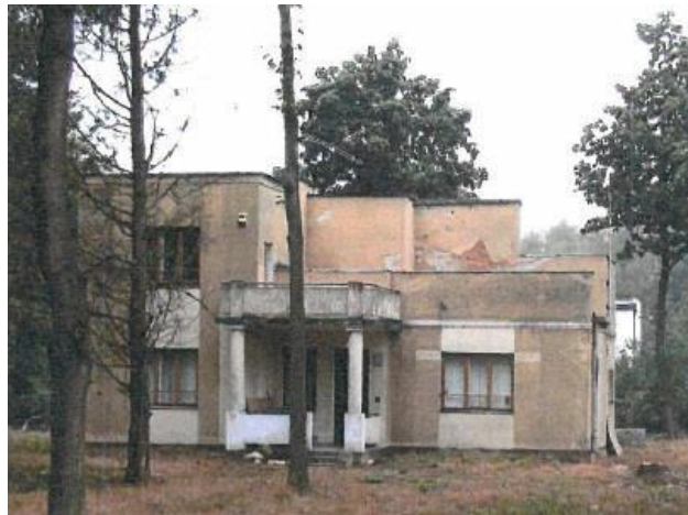
Fotografia 131. Willa przy ulicy Szpaków (działka nr ewid. 80, obręb 3)
