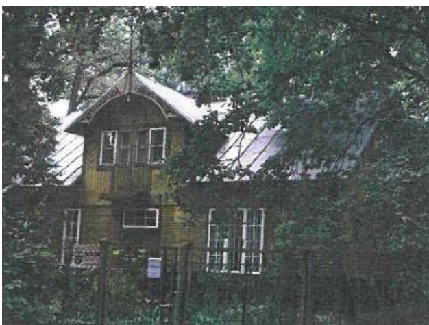
Fotografia 161. Dom przy ulicy Żeromskiego (działka nr ewid. 93, obręb 10)
