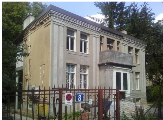
Fotografia 228. Dom wielorodzinny przy ulicy Lotniczej (działka nr ewid. 81, obręb 4) Fotografia własna
