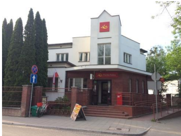
Fotografia 57. Budynek poczty – ulica Słowicza Fotografia własna
