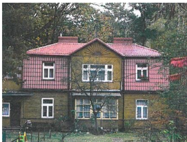
Fotografia 146. Dom przy ulicy Żeromskiego (działka nr ewid. 42, obręb 10)
