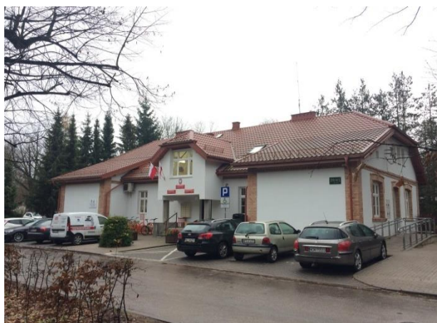
Fotografia 62. Budynek Urzędu Miasta Fotografia własna
