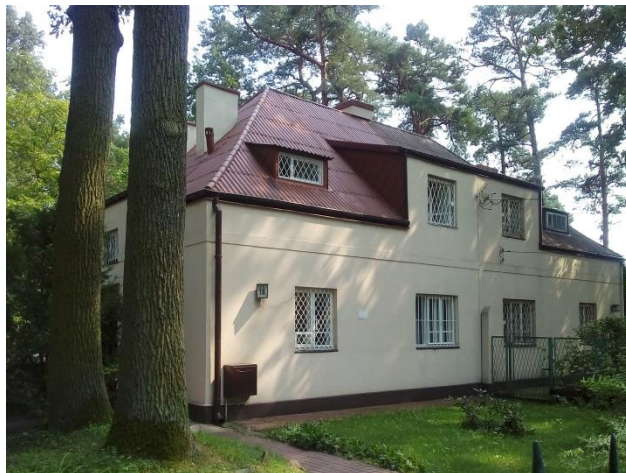
Fotografia 214. Dom jednorodzinny przy ulicy Mickiewicza (działka nr ewid. 121, obręb 10)
