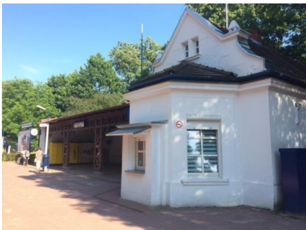
Fotografia 60. Budynek stacji WKD „Podkowa Leśna” Fotografia własna
