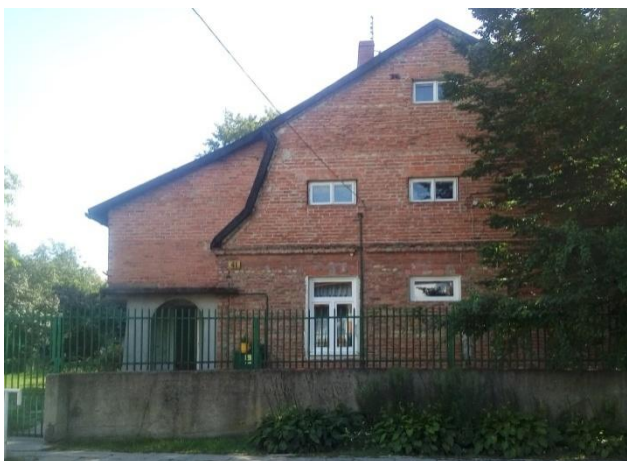
Fotografia 229. Willa Błękit przy ulicy Modrzewiowej (działka nr ewid. 119, obręb 11) Fotografia własna
