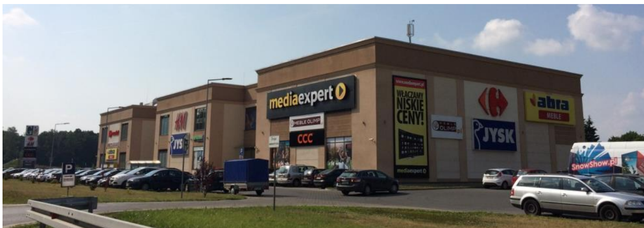
Fotografia 205. Miejsce wymagające poprawy stanu ładu przestrzennego: Galeria Podkowa – brak zieleni wysokiej Fotografia własna
