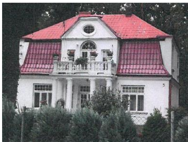
Fotografia 89. Willa przy ulicy Żeromskiego (działka nr ewid. 32, obręb 10)
