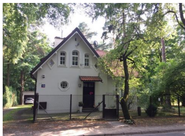
Fotografia 71. Dom przy ulicy Lipowej (działka nr ewid. 61, obręb 7)
