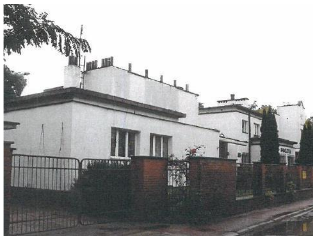
Fotografia 105. Budynek stacji automatów telefonicznych Źródło: Szuliński J. 2008 Gminna ewidencja zabytków...
