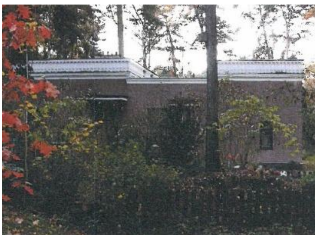
Fotografia 210. Willa przy ulicy Lipowej (działka nr ewid. 7, obręb 7)
