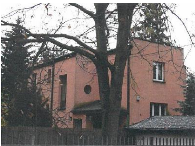
Fotografia 126. Dom przy ulicy Helenowskiej (działka nr ewid. 150, obręb 4)
