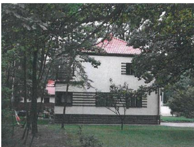
Fotografia 118. Willa przy ulicy Bluszczowej (działka nr ewid. 28, obręb 9)
