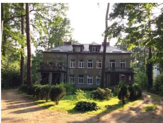
Fotografia 42. Zabudowa wielorodzinna – ulica Jaworowa Fotografia własna
