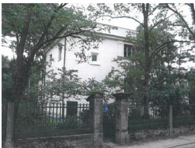
Fotografia 119. Willa przy ulicy Bukowej (działka nr ewid. 160, obręb 12)
