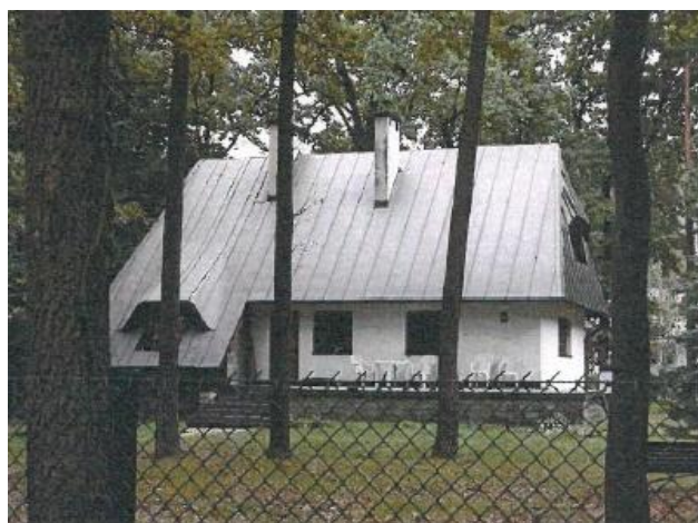
Fotografia 95. Dom przy ulicy Słowackiego (działka nr ewid. 69, obręb 10)
