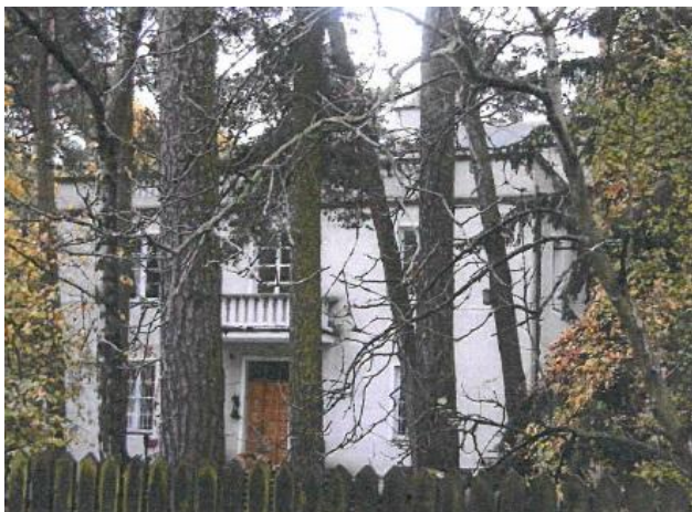
Fotografia 67. Dom przy ulicy Wiewiórek (działka nr ewid. 17, obręb 5)
