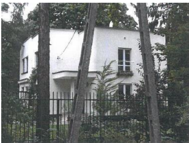
Fotografia 106. Dom przy ulicy Sienkiewicza (działka nr ewid. 47, obręb 10)
