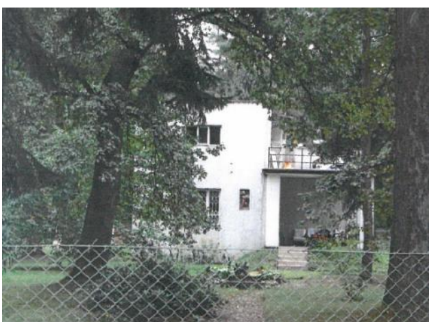
Fotografia 108. Willa Sosenka przy ulicy Dębowej (działka nr ewid. 150, obręb 12)
