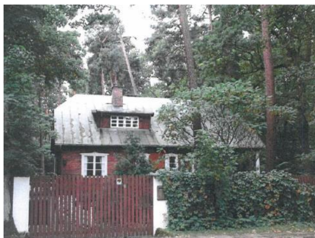
Fotografia 156. Dom przy ulicy Lilpopa (działka nr ewid. 36, obręb 8)
