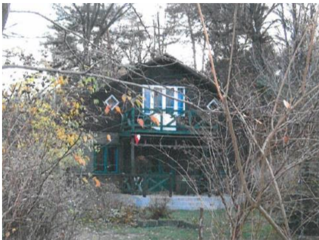
Fotografia 151. Dom przy ulicy Bukowej (działka nr ewid. 127, 128, obręb 12)
