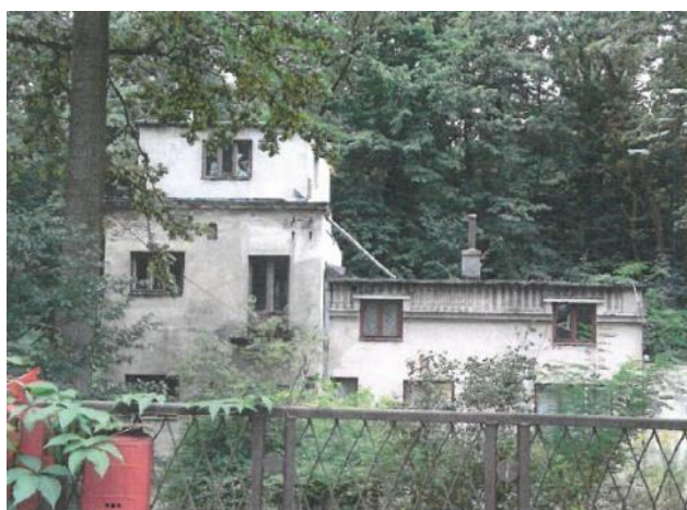
Fotografia 137. Dom wielorodzinny Wiosenka przy ulicy Sosnowej (działka nr ewid. 190, obręb 12)
