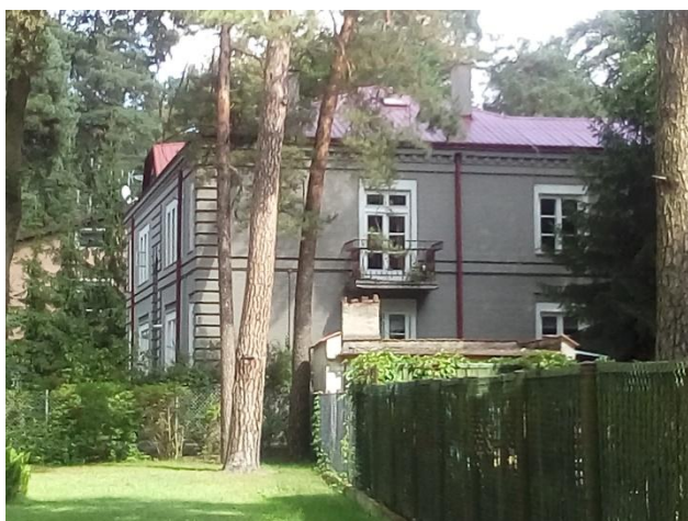
Fotografia 223. Dom wielorodzinny przy ulicy Borsuczej (działka nr ewid. 19, obręb 6)
