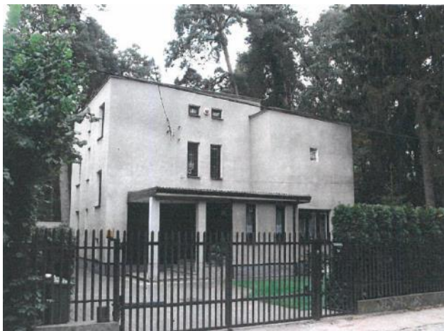
Fotografia 120. Willa przy ulicy Bukowej (działka nr ewid. 145, obręb 12)
