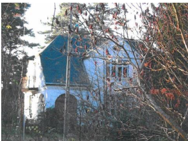
Fotografia 88. Willa przy ulicy Kasztanowej (działka nr ewid. 137, obręb 11)
