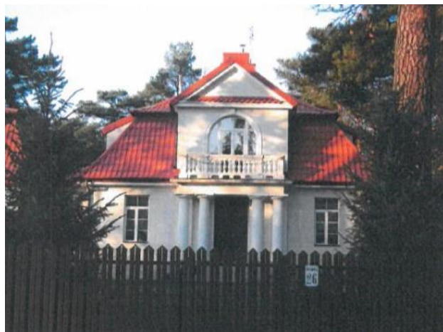
Fotografia 87. Willa przy ulicy Bukowej (działka nr ewid. 70, obręb 12)
