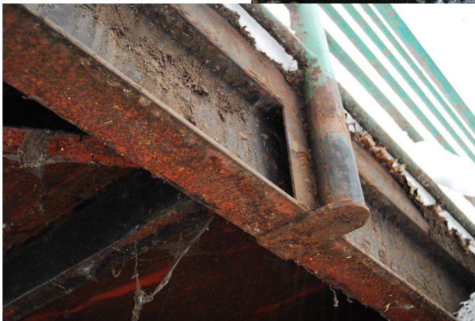
Park Miejski w Podkowie Leśnej Stan istniejący
