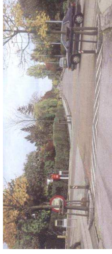
Zdj. 4.51. Skrzyżowanie na powierzchni wyniesionej
