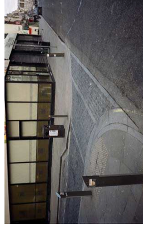
Zdj. 4.56, Zdj. 4.57. Przykłady zastosowania przejść i przejazdów rowerowych na powierzchniach wyniesionych
