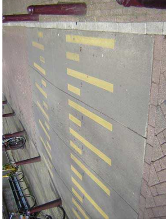
Zdj. 4.45 Próg prefabrykowany
