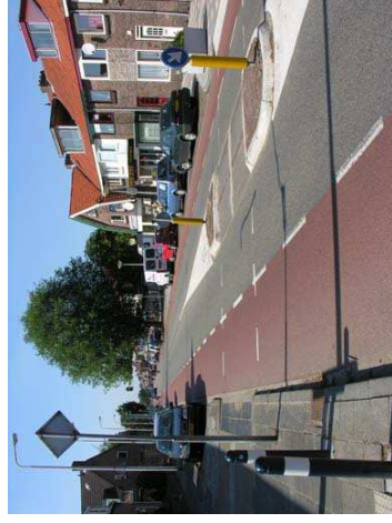
Zdj. 4.25, Zdj. 4.26. Zwężenie przekroju ulicy poprzez wyznaczenie pasów dla ruchu rowerowego
