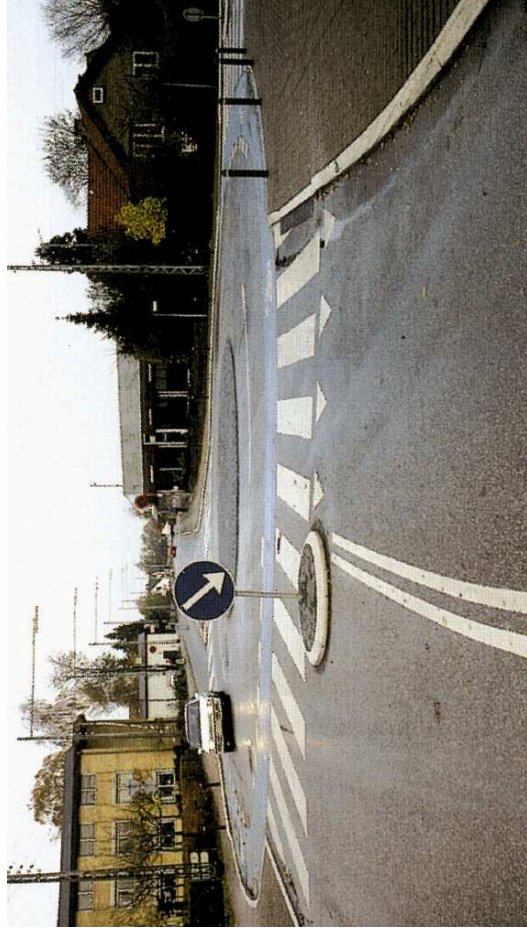
Zdj. 3.6. Rondo stanowiące bramę wjazdową do strefy 30 km/h
