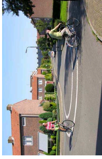
Rys. 4.15, Zdj. 4.16. Wprowadzenie ronda bez przebudowy geometrii skrzyżowania
