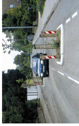
Zdj. 4.42, Zdj. 4.43. Przykłady stosowania zwężeń naprzemiennych
