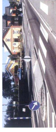
Rys 4.21. i Zdj. 4.22. Skanalizowanie ruchu przy przejazdach przez małe miejscowości.
