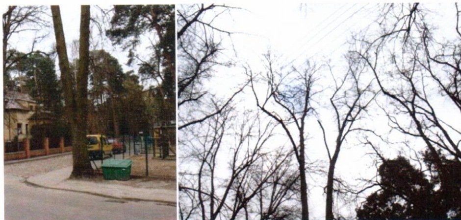
Fot.18-19: Tilia cordata nr 168-17. Rozwidlenie pnia, deformacja korony i kolizje z linią energetyczną
