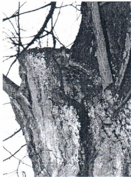
Fot.10. Resztki starej plomby betonowej,
