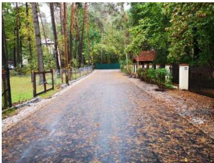
Rysunek 10 Zmodernizowana ulica Grabowa
