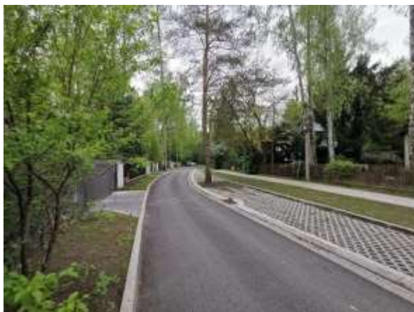
Rysunek 5 Zmodernizowana ul. Helnowska
