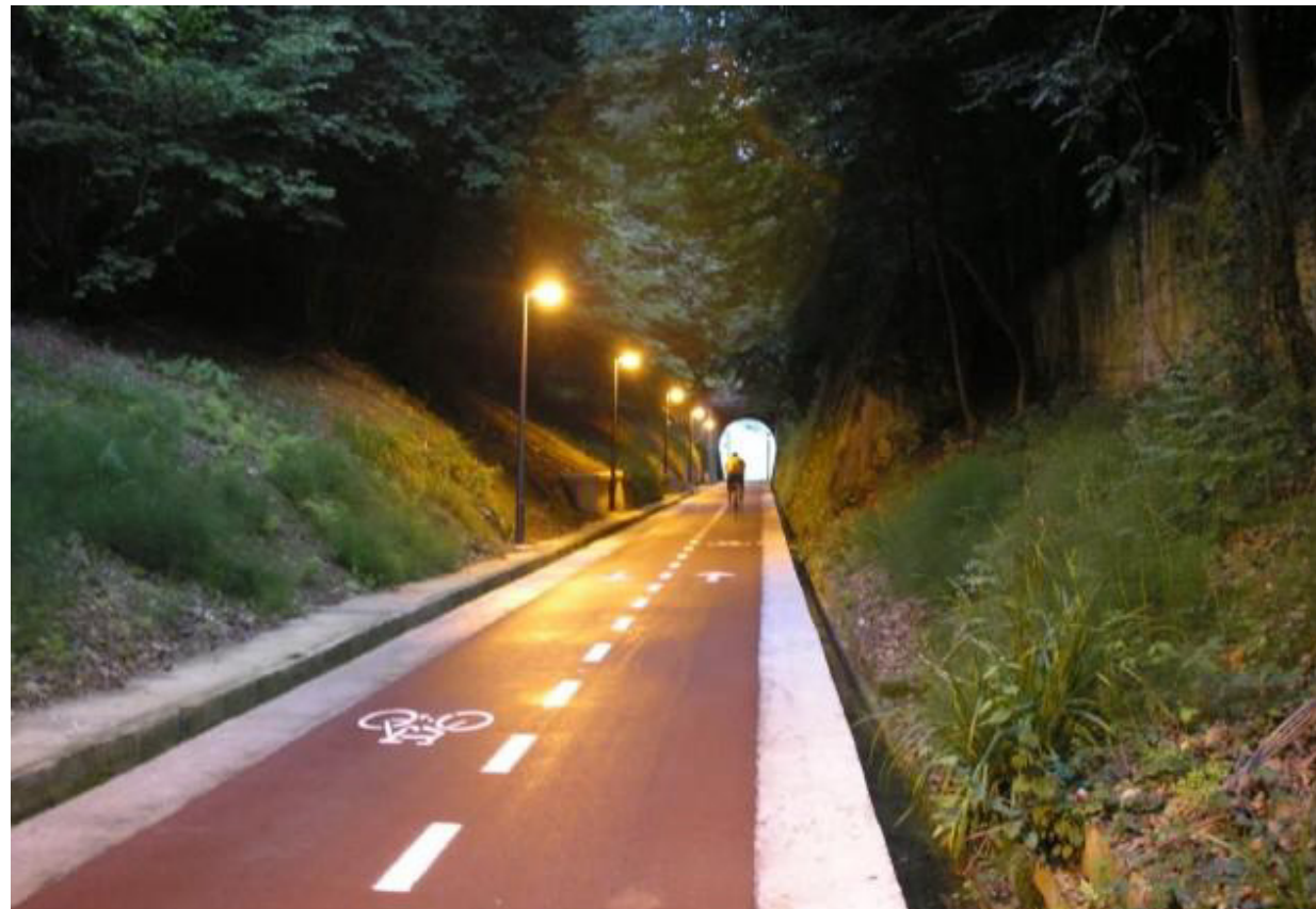
Wykorzystanie dawnej infrastruktury kolejowej
