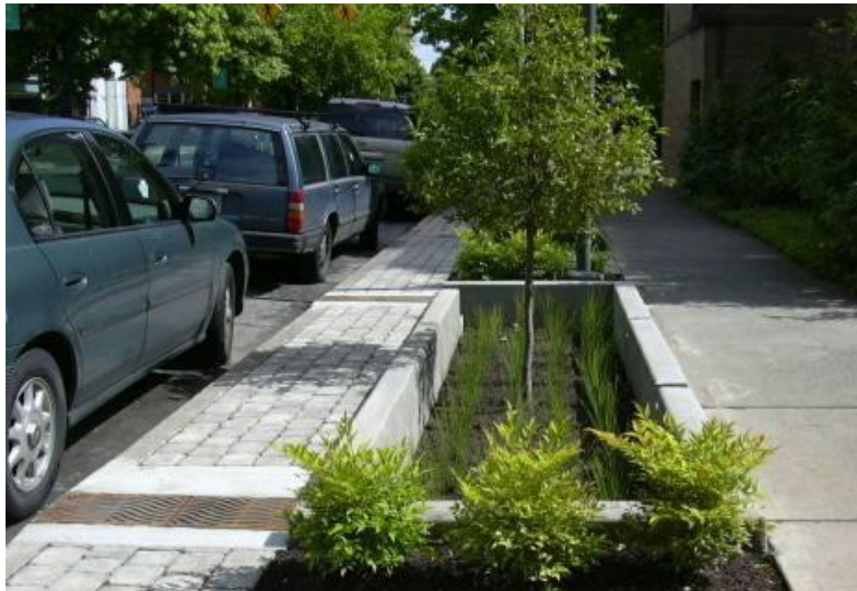
12th Avenue Green Street Project, Portland, USA, General Design Award of Honor za wprowadzenie systemu retencji wód opadowych w przestrzeni ulicy
