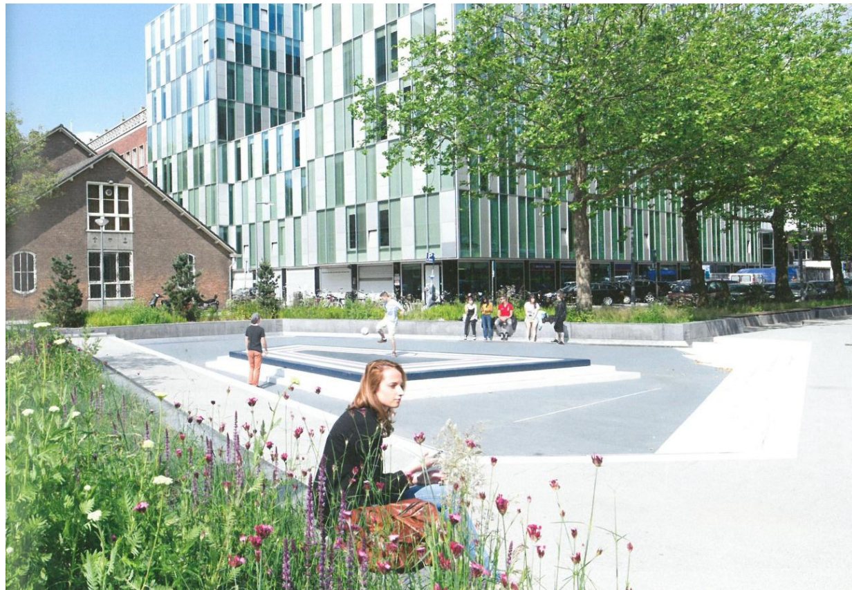
Bentemplein, projekt De Urbanisten placu użytkowanego w czasie suchej pogody jako miejsce sportu, a w czasie deszczu zbiornik retencyjny o pojemności 1700 m 3
