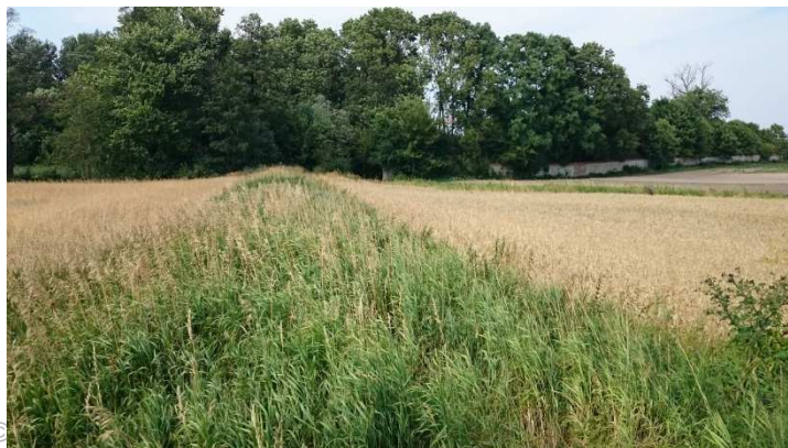
Fot. 4. Wał przeciwpowodziowy w Czubinie
