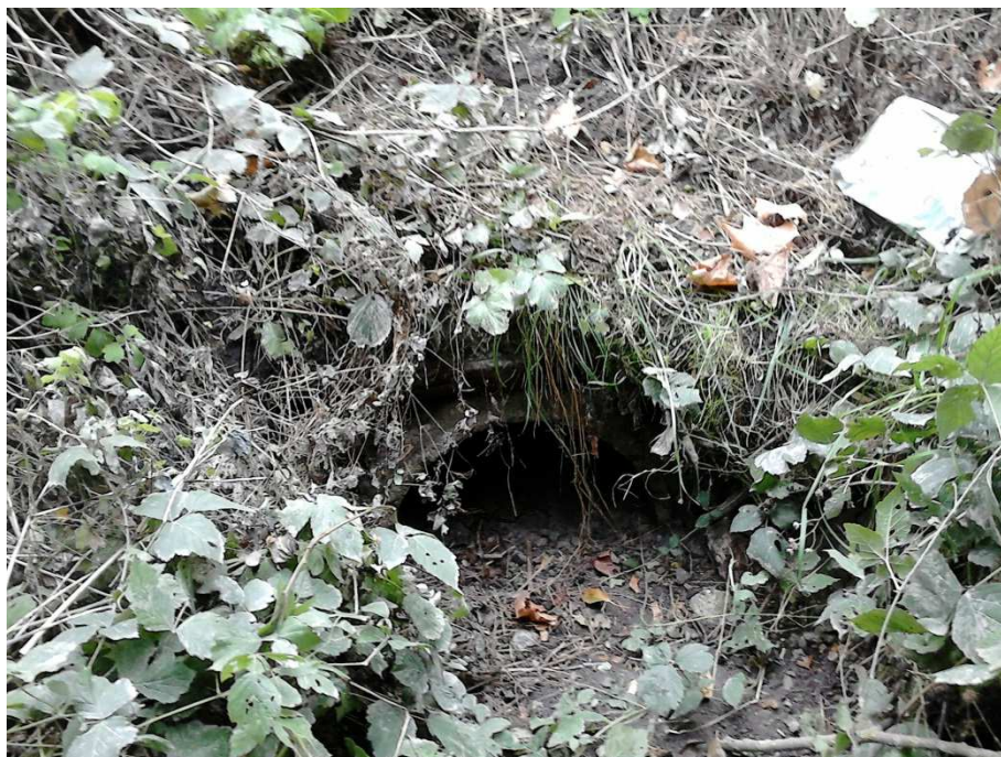
Zdjęcie 1. Zamulony przepust na rowie RS-11 pod ulicą Graniczną w Żółwinie
