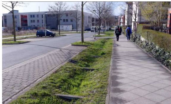
Zdjęcie 35. Rów typu „Swale” w Hanowerze, z widocznymi przegrodami oraz wpustem wody z jezdni i parkingu
