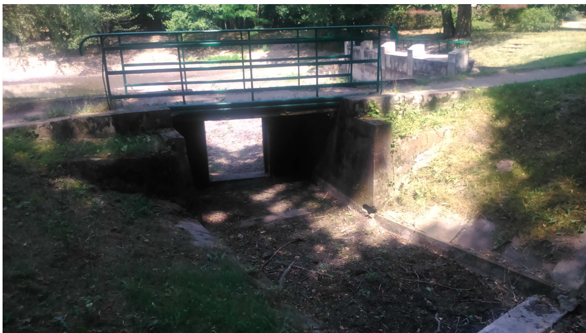
Rysunek 11. Przepust betonowy na wlocie do zbiornika o konstrukcji ramowej, z betonową kładką dla pieszych
