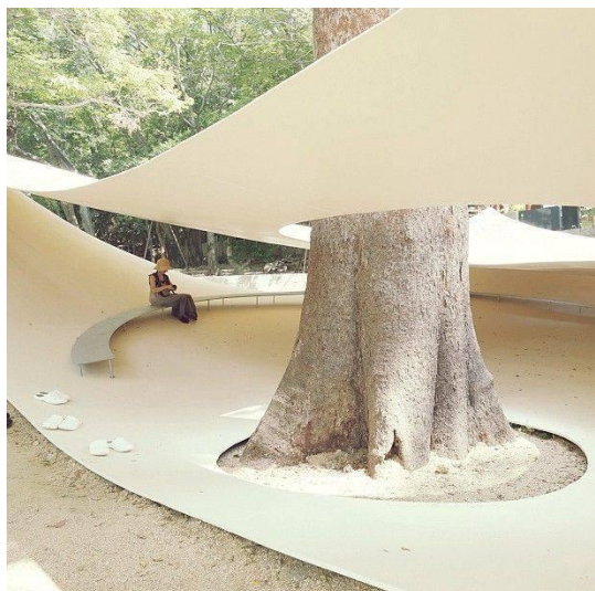
Rys. 50 Pawilon Sanktuarium Fukita wykonany z dwóch dużych arkuszy metalu z wyciętymi otworami na dominujący w jego strukturze soliter
