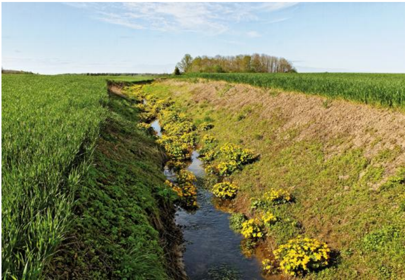
Rys. 39 Rów melioracyjny po konserwacji
