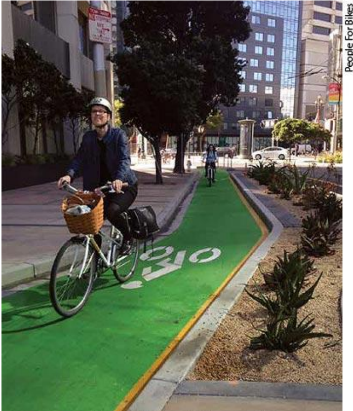
Rys. 8 Zagłębiona ścieżka rowerowa w San Francisco, USA, wydzielona od drogi rabatą – barwna nawierzchnia
