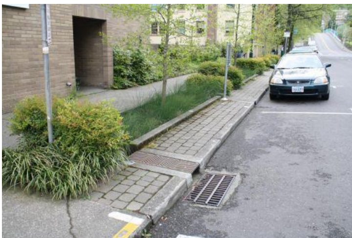
Rys. 16 Nagroda General Design Award of Honor dla SW 12th Avenue Green Street Project w mieście Portland, USA za wprowadzenie systemu retencji wód opadowych w przestrzeni ulicy
