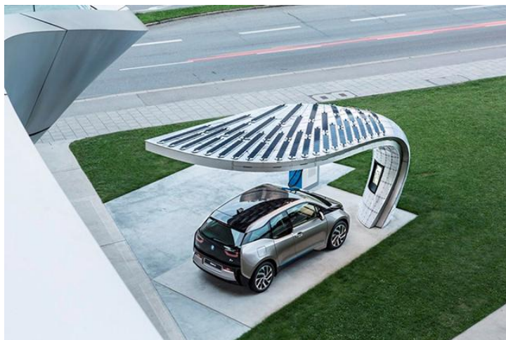
Rys. 46 Stacja ładowania aut elektrycznych BMW przy użyciu paneli solarnych
