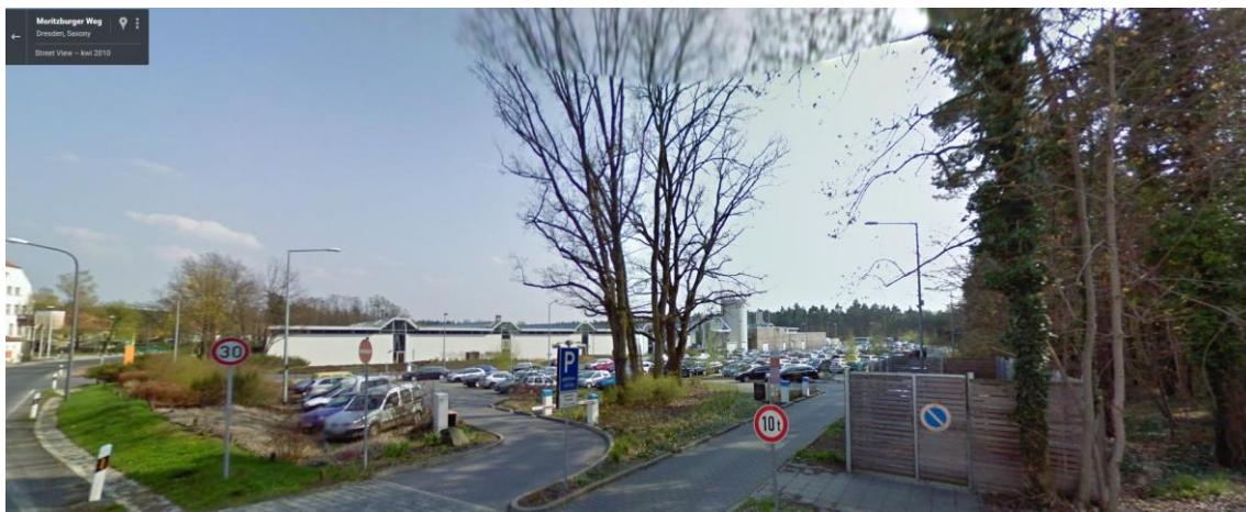
Fot. 29 Ekologiczne rozwiązanie odpływu wód z parkingu
