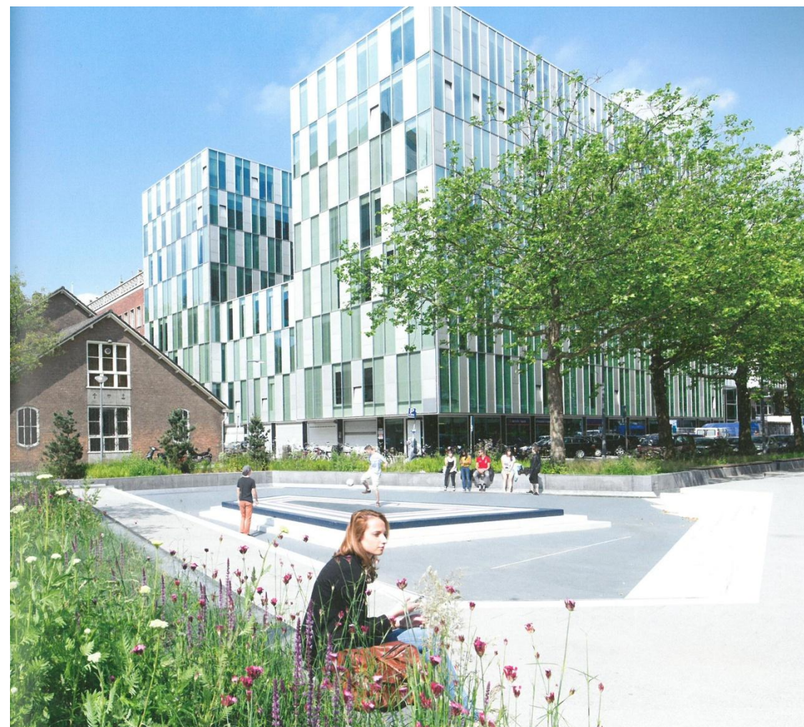
Fot. 25 Benthemplein, projekt De Urbanisten placu użytkowanego w czasie suchej pogody jako miejsce sportu, a w czasie deszczu zbiornik retencyjny o pojemności 1700 m 3
