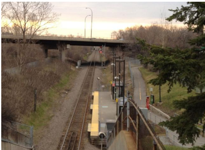
Fot. 60 Droga rowerowa, po południowej stronie Heron Road, Ottawa
