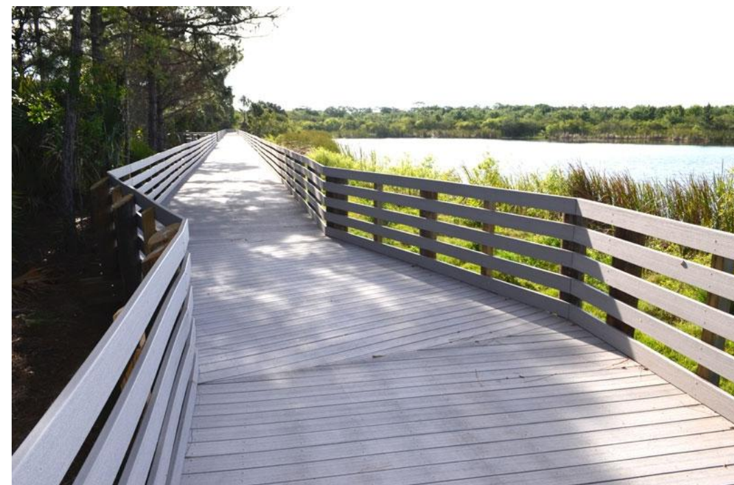
Fot. 80 Przykład ścieżki nad jeziorem, wykonanej z przetworzonego plastiku
