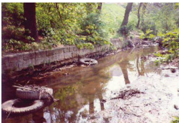
Stan przed rozpoczęciem rewitalizacji (©Šindlar, s.r.o.)
