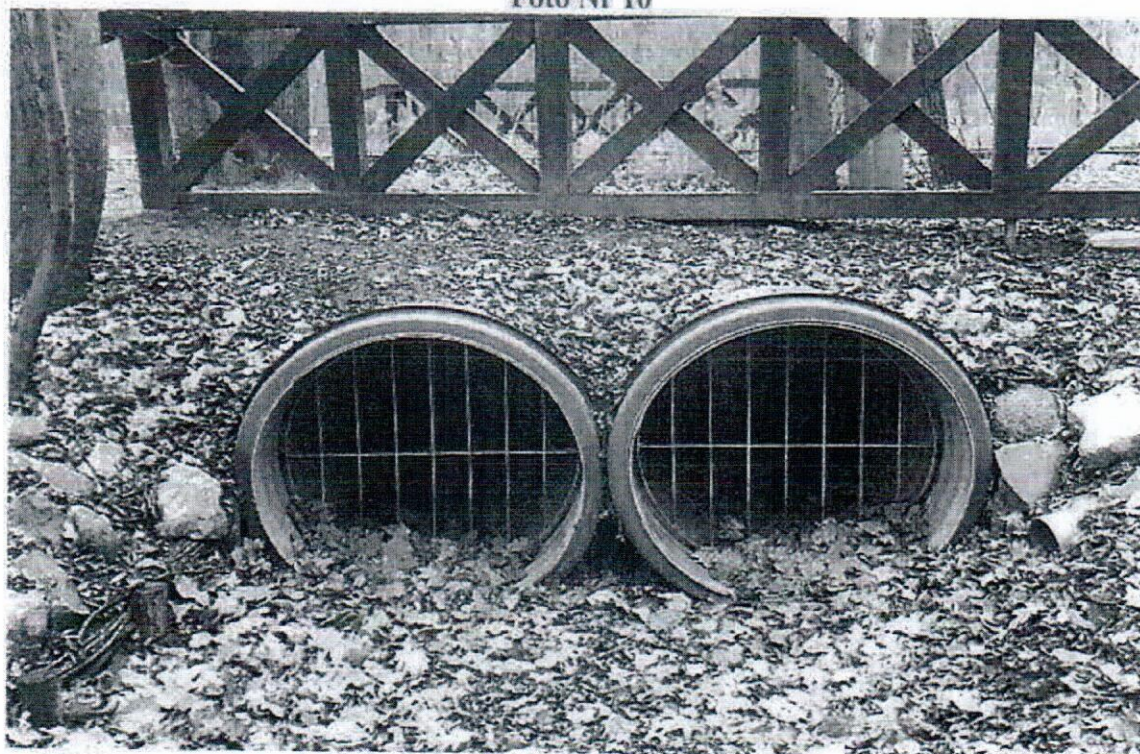
BUDOWLA UPUSTOWA BARIERKI ORAZ UMCNIENIE KORYTA ROWU W STREFIE PÓLNOOCNEJ
