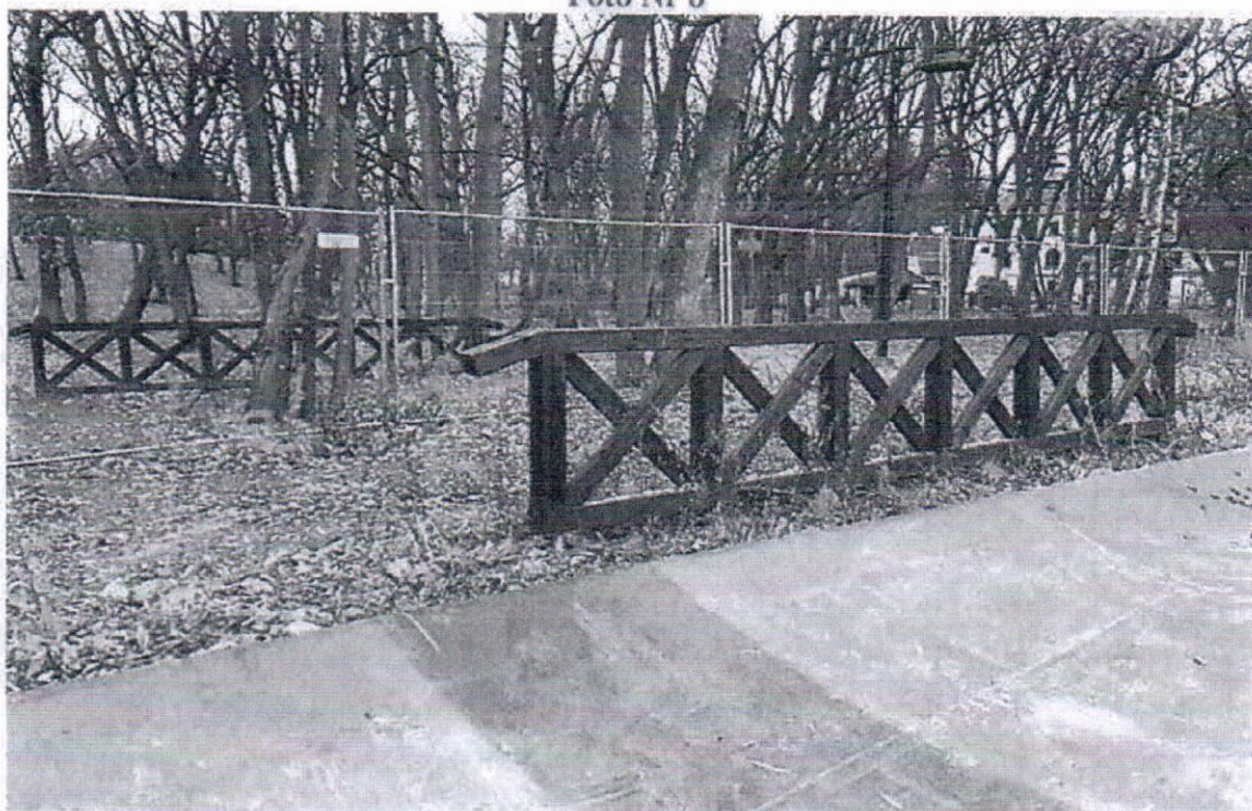
STREFA PÓLNOČNA BARIERKI W REJONIE BUDOWLI UPUSTOWEJ
