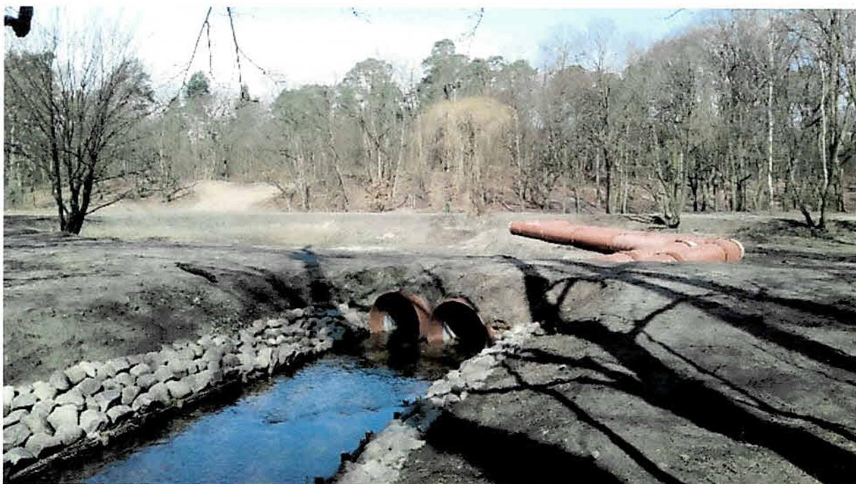
fot. 2 przedstawia sposób umocnienia dna i skarp rowu (umocnienie kamieniami oraz wyraźnie widoczną kieszkę faszynową) wg rozwiązania przewidzianego w projekcie budowlanym wraz z odcinkiem koniecznym do wykonania z uwagi na dopuszczenie rozwiązania zamiennego technologii wykonania budowli wpustowych i upustowych – stan styczeń/luty 2018 r. Budowla wpustowa.
