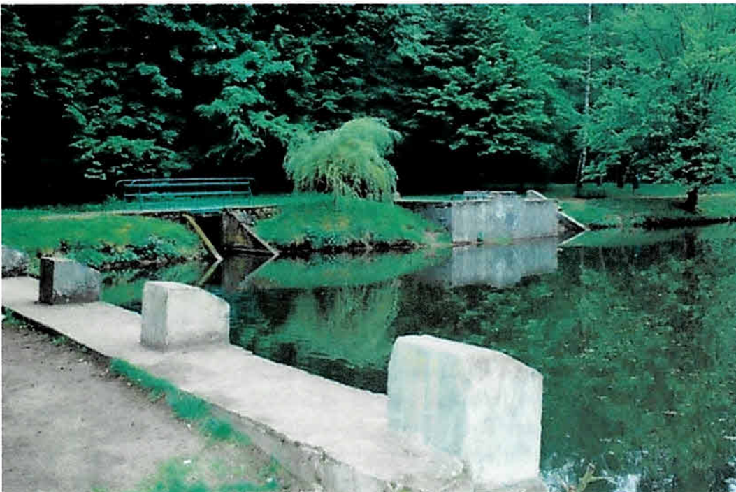
Zdjęcie nr 1. Nabrzeże pływakie, taras ze schodami oraz budowla wpustowa. Rok 2013
