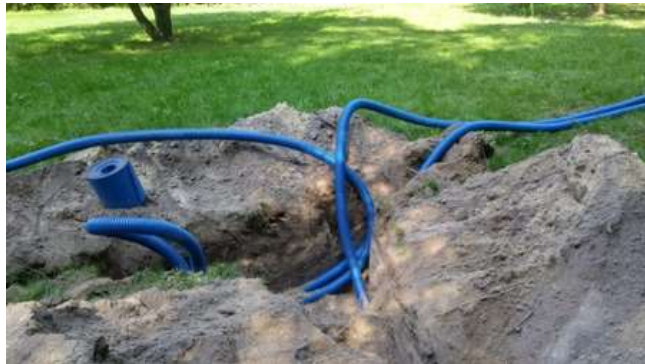
Rysunek 19 Rozprowadzenie instalacji w kanałach ziemnych
